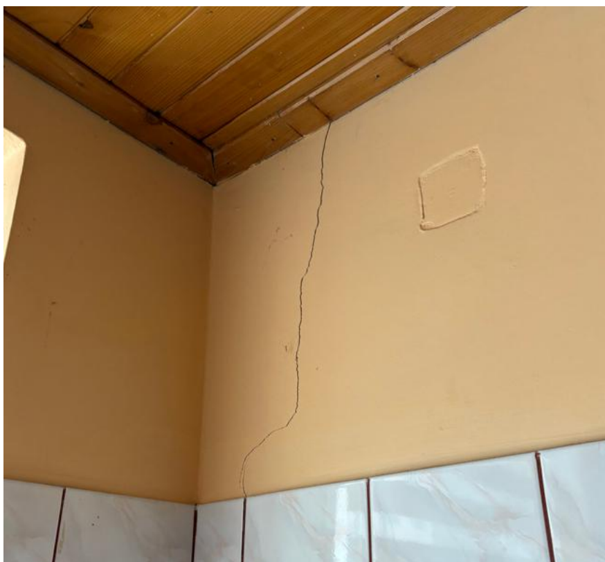
Spękanie w ścianie wewnętrznej – zachodniej - usztywniającej ścianę szczytową
