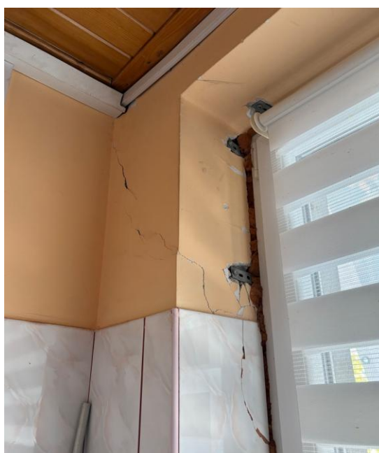
Spękanie w ścianie szczytowej – zachodniej
