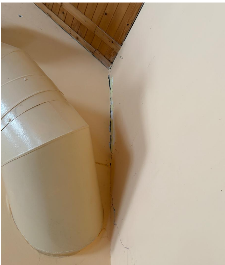
Spękanie na styku ściany zewnętrznej i wewnętrznej w części wschodniej
