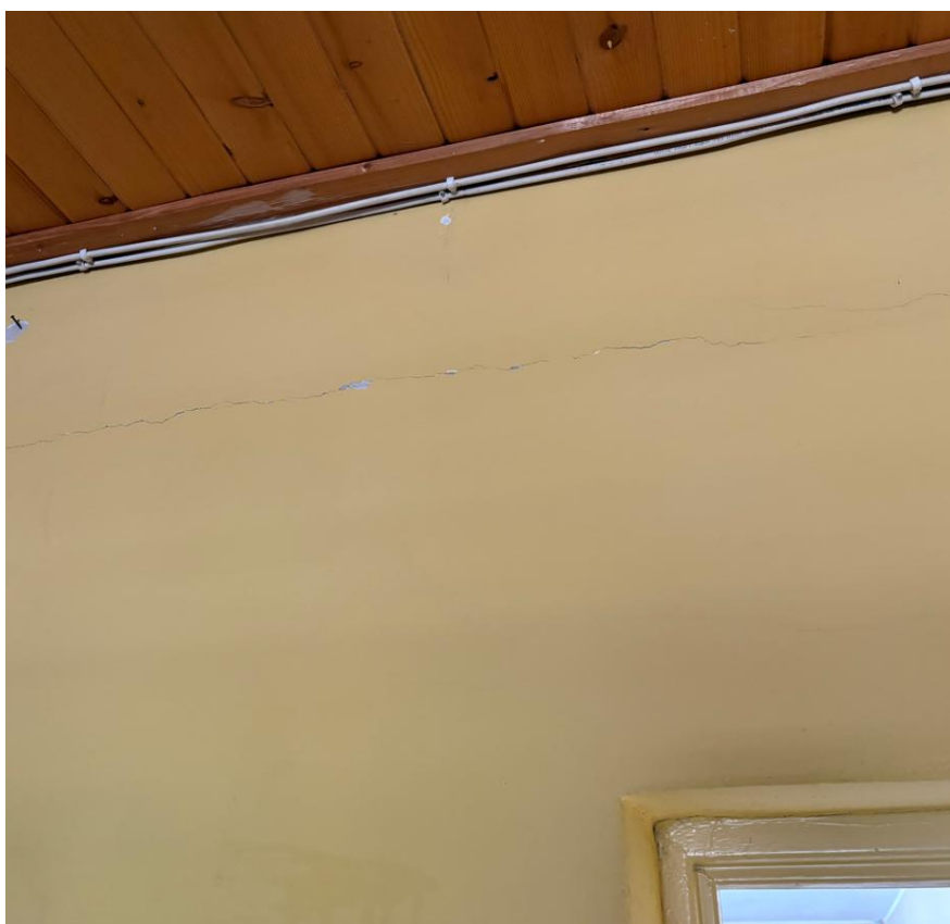
Spękanie w ścianie wewnętrznej – zachodniej
